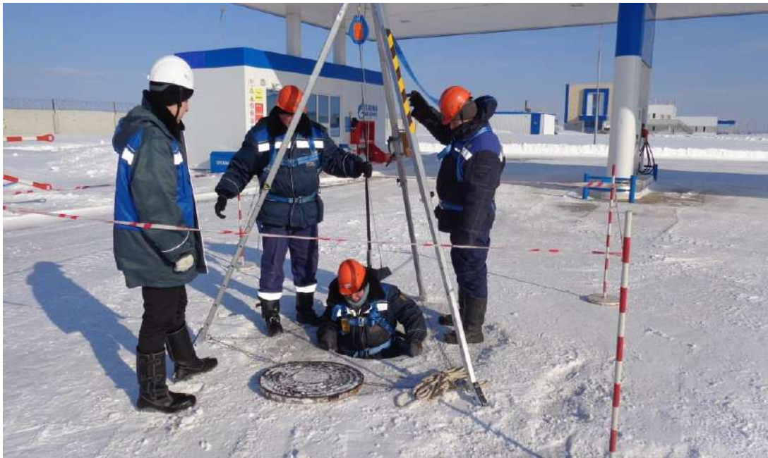
Рисунок 23 Работа в колодцах с применением штатива «Трипод
